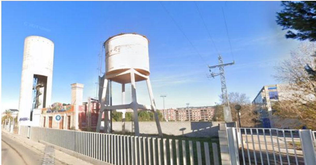
Figura 5. Imagen del entorno urbano y del estado actual del ámbito de intervención (obtenida a partir de Google Street View).
